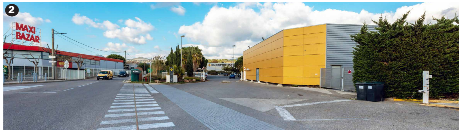
2 Vue depuis l'angle Sud-Ouest de la parcelle, au niveau de l'entrée de l'enseigne et de l'Hôtel B&B.
