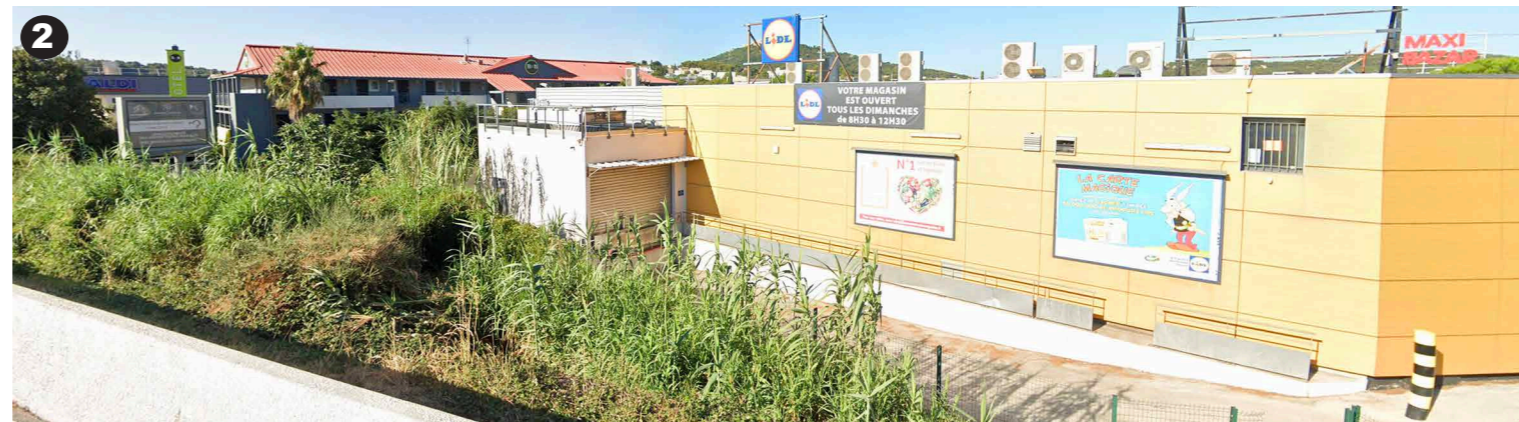
2 Vue depuis la RD 26 vers le quai de livraison. Quai de déchargement du magasin existant.
